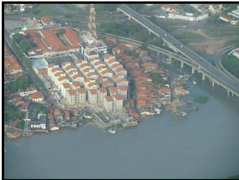
Figura 5. Residencial Rio Anil Camboa, São Luís - MA. Fonte: http://vimarenses.zip.net/arch2009 . Acesso em 16.mar.2013
